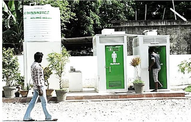
Typical efficient Namma Toilet/ E Toilet
